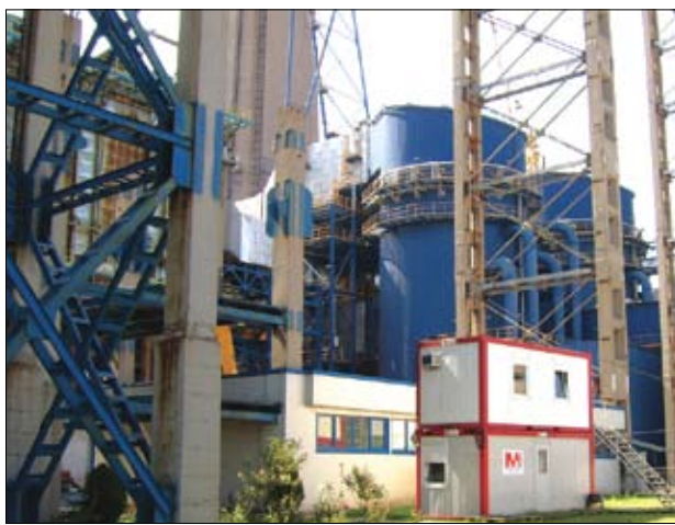
Ето я и сероочистката на седми и осми блок
